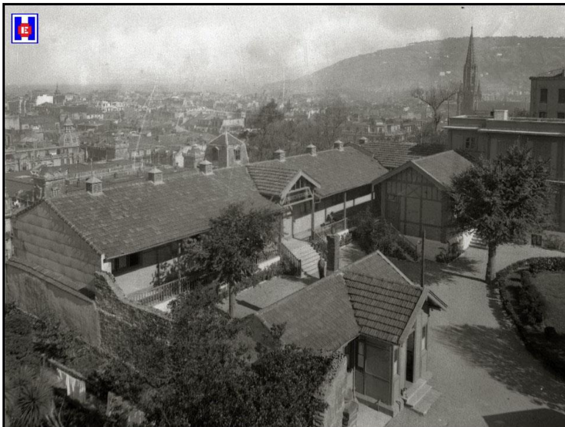
FOTO 14 Fachada del Asilo de Caridad. Foto Pascual Marín
