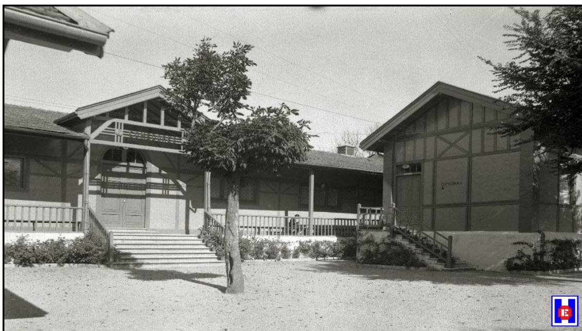
FOTO 10 Pabellón de Oficinas del Asilo de Caridad. Foto Pascual Marín
